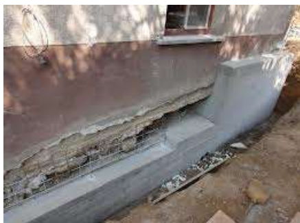
Fotografija 17: Primer hidroizolacije starejše hiše
