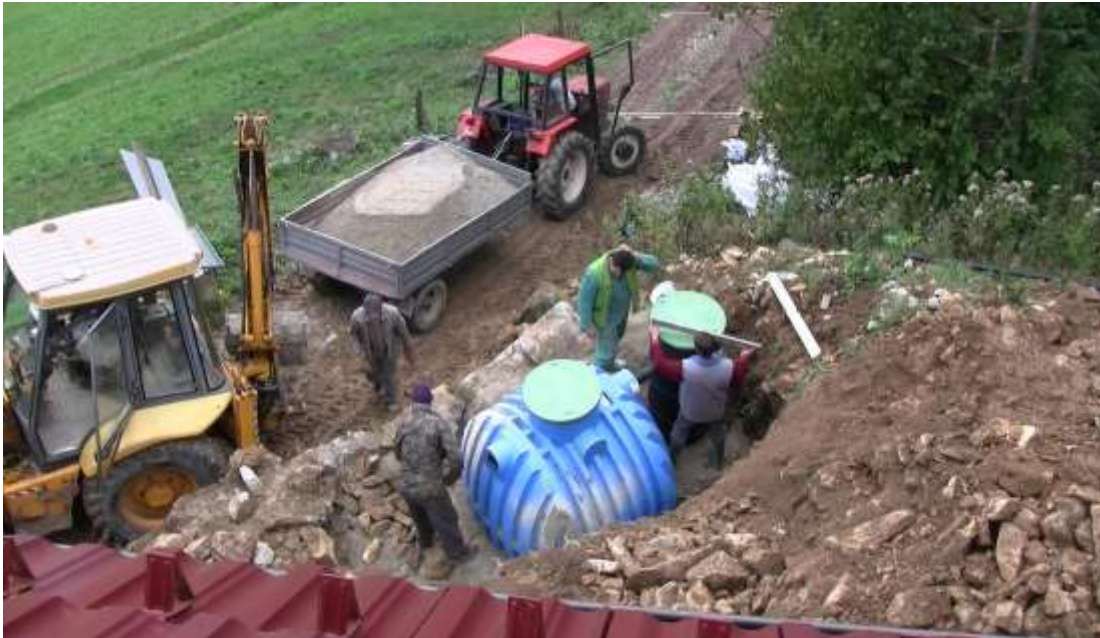
Slika 6 Vgradnja vsedalnika
