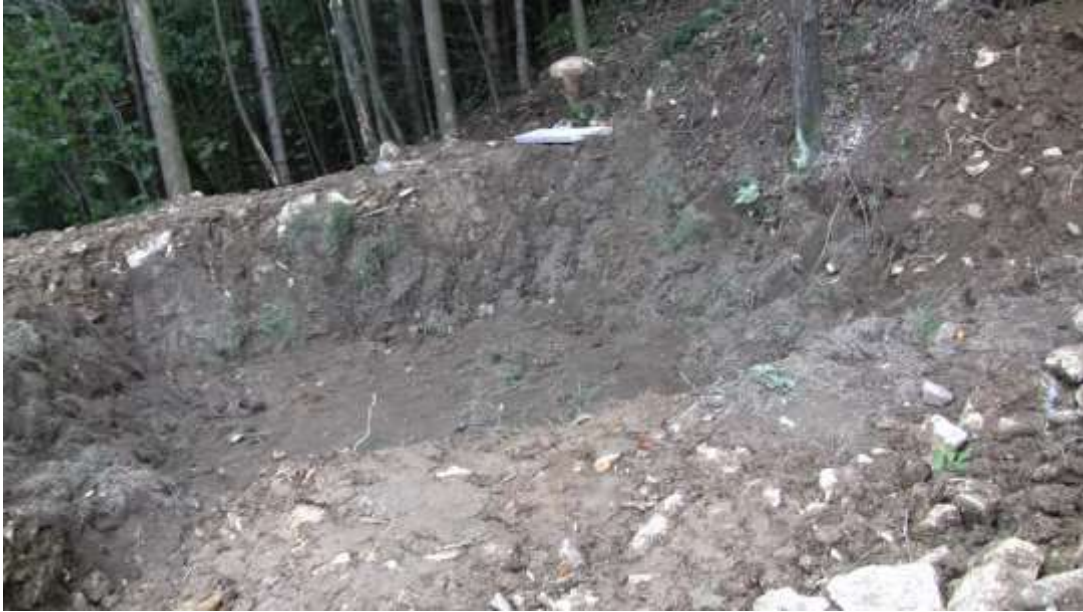
Slika 3 Izkopana luknja za vgradnjo
