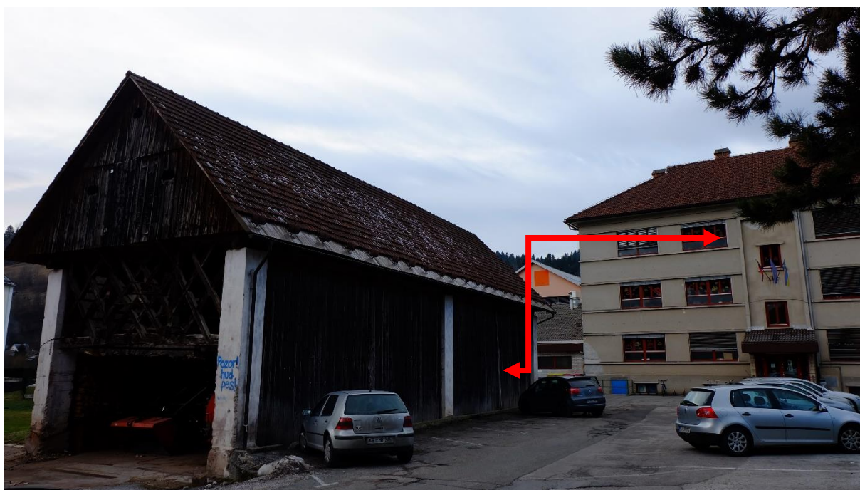
Slika 17: Pogled na šolo/kozolec z jugozahodne smeri
