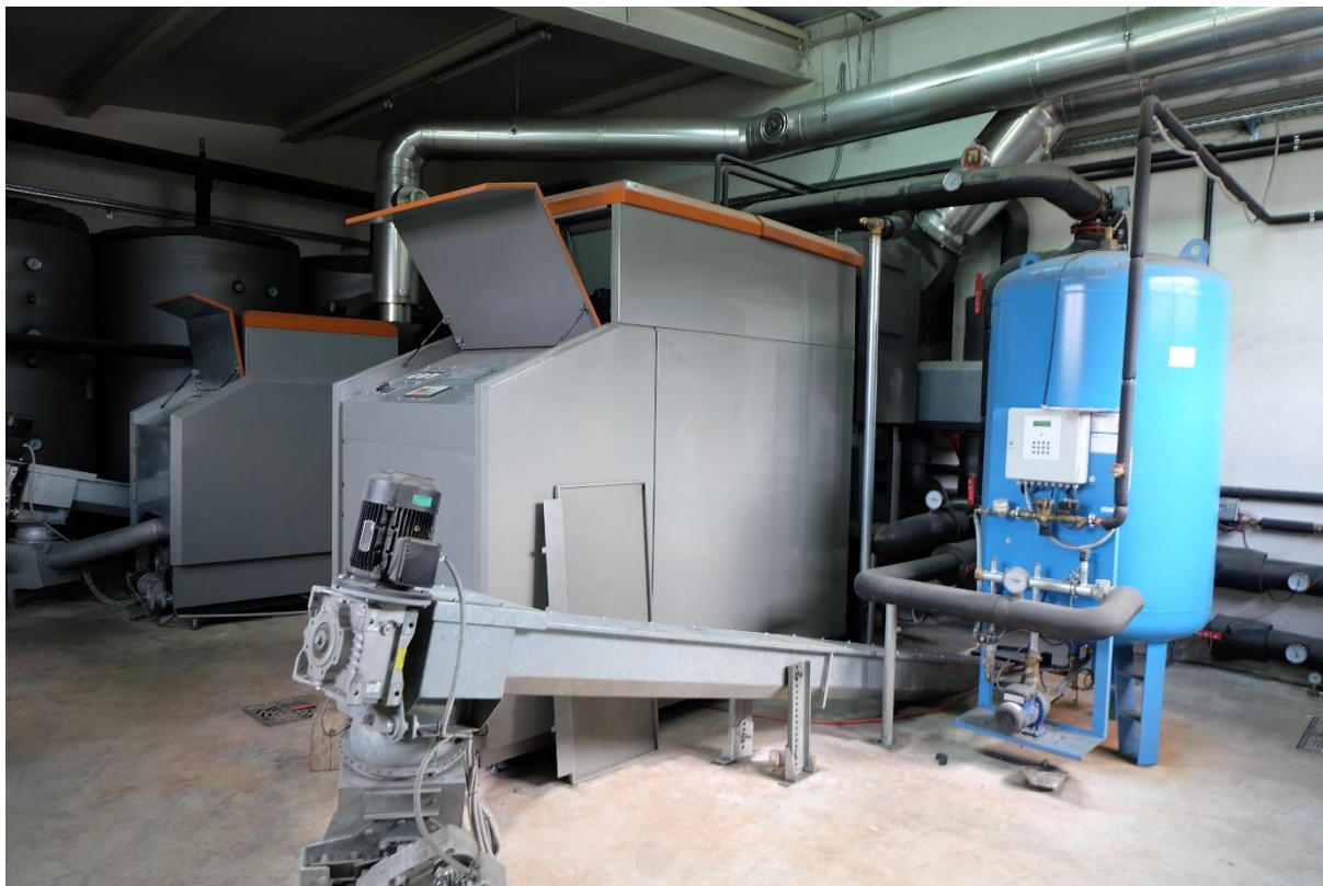
Slika 3: V cevi se sekanci ločijo od morebitnih primesi (kamnov)
